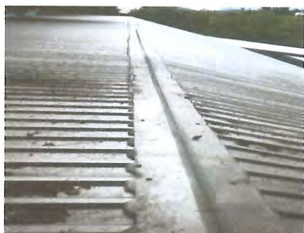
FOTO 3: CUBIERTA DE LAMINA
