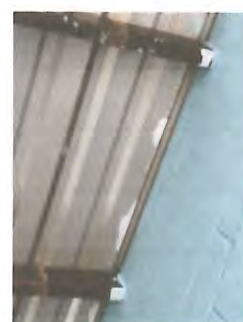
FOTO 6: CUBIERTA DE LAMINA
