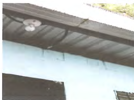
FOTO 4: CANALES Y BAJADAS DE AGUA PLUVIAL
